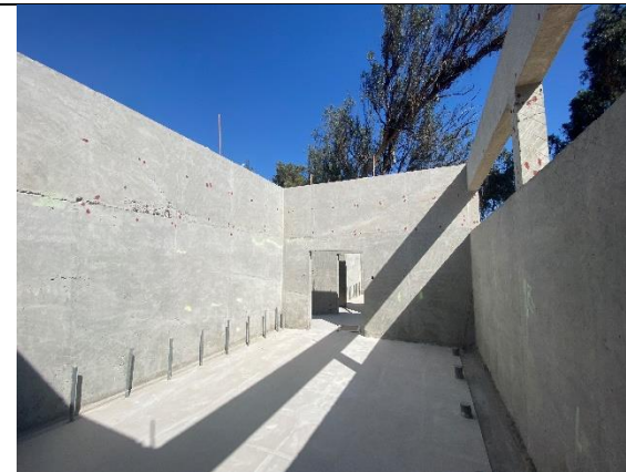
Imagen N° 1: Vista parcial edificio Centro de Eventos.
