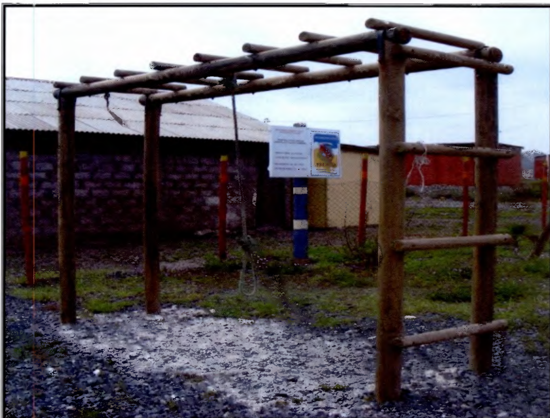
Fotos No. 22 Faltan los refuerzos diagonales
