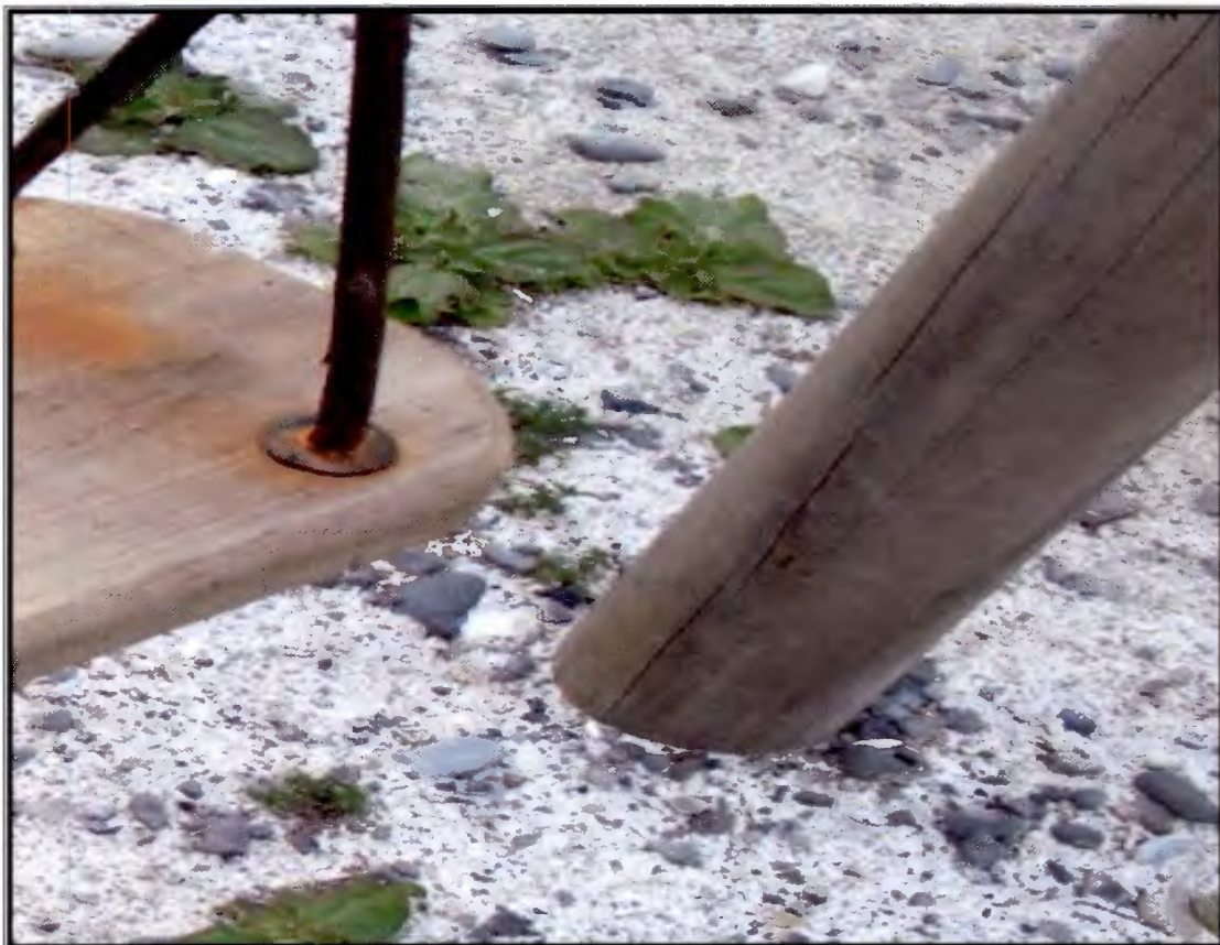
Fotografía No. 20 Ausencia de zunchos metálico
