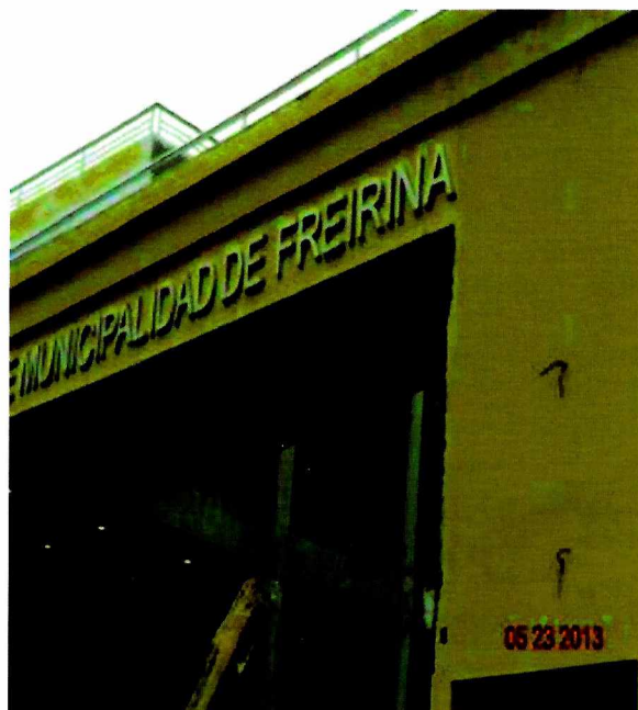
Fotografía N° 40: Estado de la obra, posterior a la designación de la comisión de recepción provisoria
