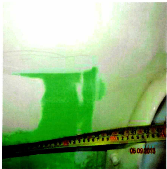
Fotografía N° 24: Medida tomada en el lugar no concuerda con el proyecto.
