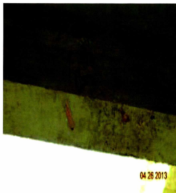
Fotografía N° 14: Armadura sin recubrimiento y con presencia de oxido.
